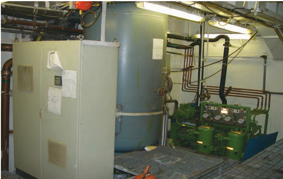
شکل ۱۷- سامانه هوای فشرده
