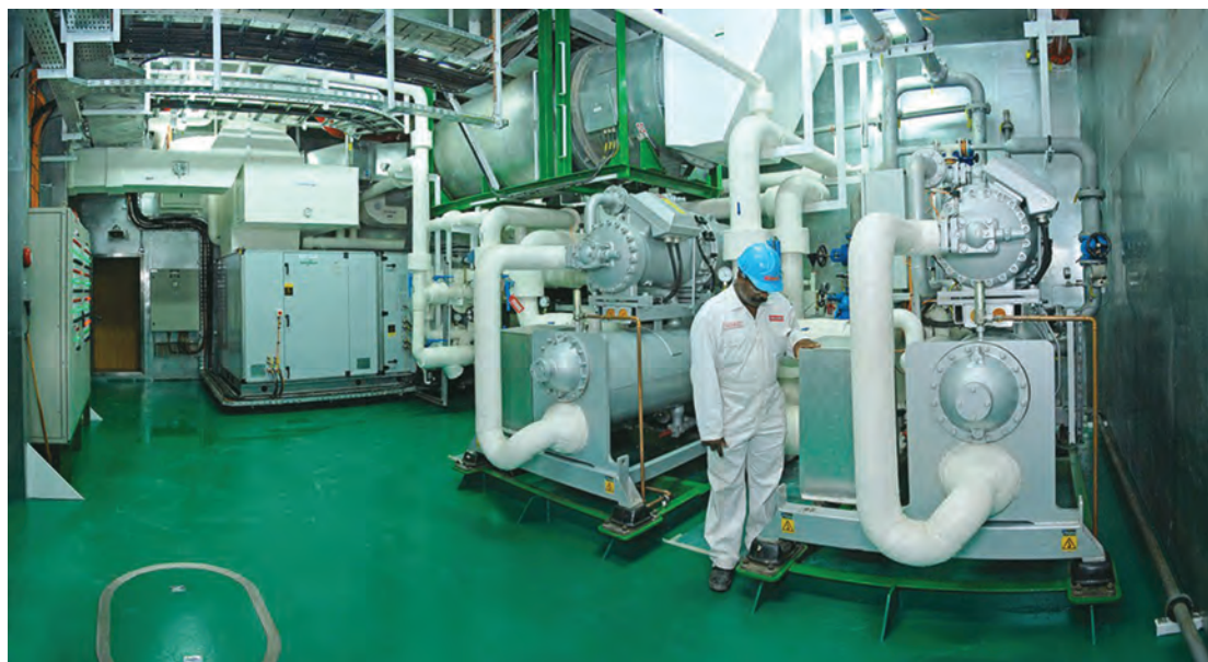
شکل ۲- نمونه‌ای از سامانه تهویه مطبوع در شناور
