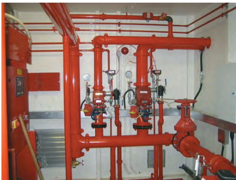
شکل ۱۰- قسمتی از سامانه آتش‌نشانی یک شناور
