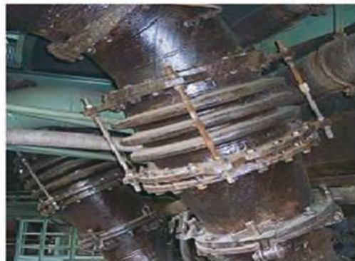
شکل ۴۳- اتصال‌های قابل انبساط
