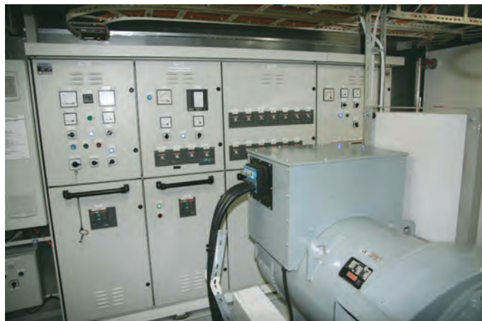
شکل ۷- تولید و توزیع برق شناور
